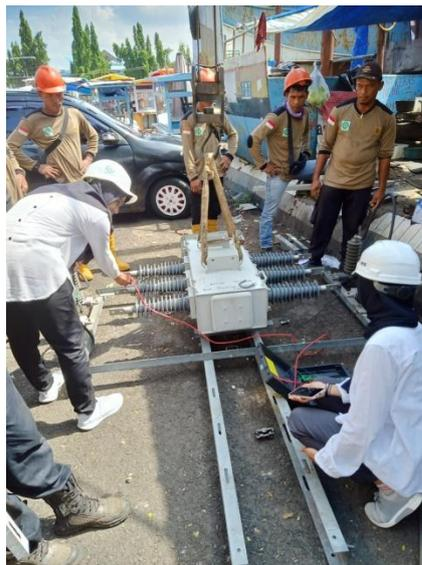
Gambar 3. 3 Pengukuran tahanan isolasi
