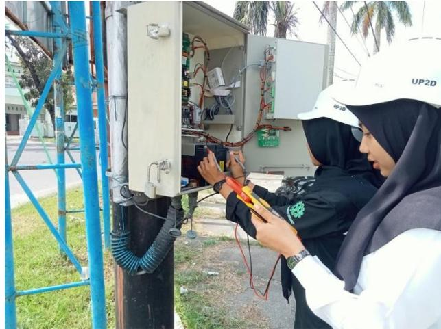
Gambar 4. 9 Pemeliharaan *Battery LBSM*
