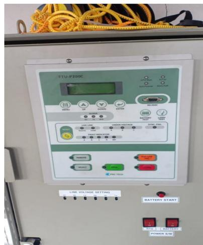
Gambar 4. 6 *Remote Terminal Unit* pada LBSM
