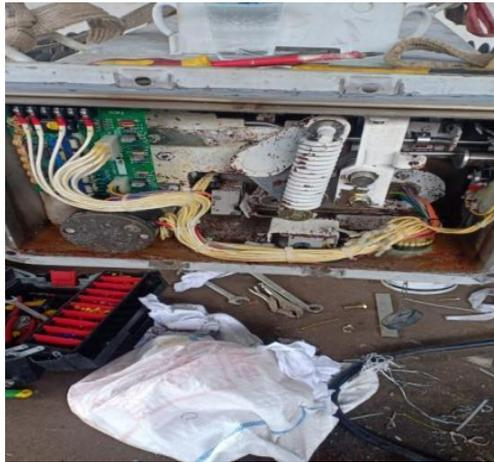
Gambar 4. 12 Pemeliharaan mekanik PMT LBSM
