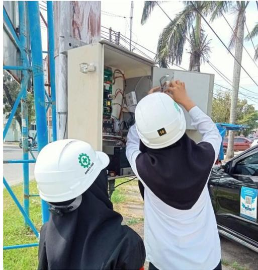
Gambar 4. 7 Perbaikan Panel *Remote Terminal Unit* pada LBSM
