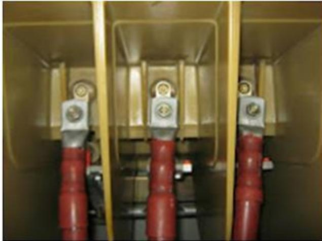
*Gambar 3. 26 Terminal Penghubung Kubikel 20KV*
