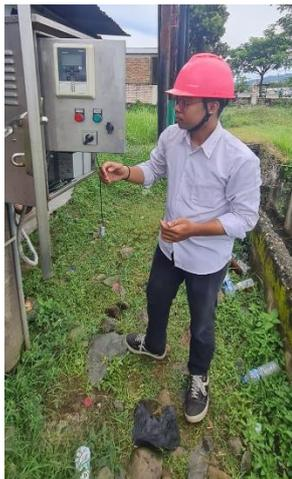
*Gambar 3. 8 Pengecekan Baterai pada LBS Raja Minas*
