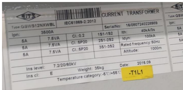
Gambar 4. 7 Rasio CT Pada Sisi 6,3 kV
