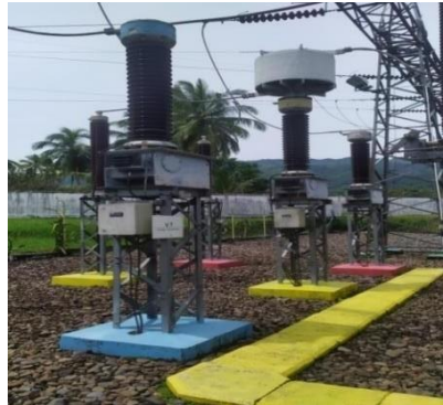
Gambar 3.12 Transformator Tegangan (VT)
