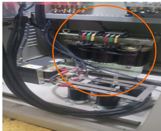
Gambar 4.11 Transformator Utama
