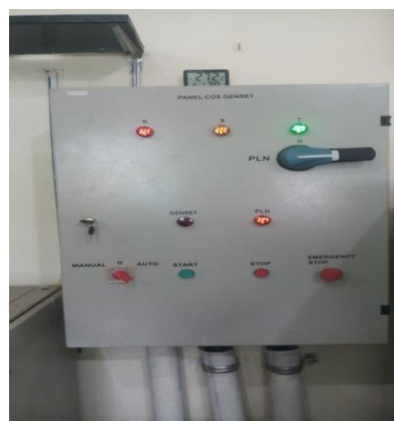
Gambar 4.5 Genset Pada Gardu Induk Solok dan Panel Control Sistem Genset
