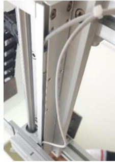
Gambar 3.49 Pemasangan Sensor Reed Switch pada Silinder Forward Reverse
