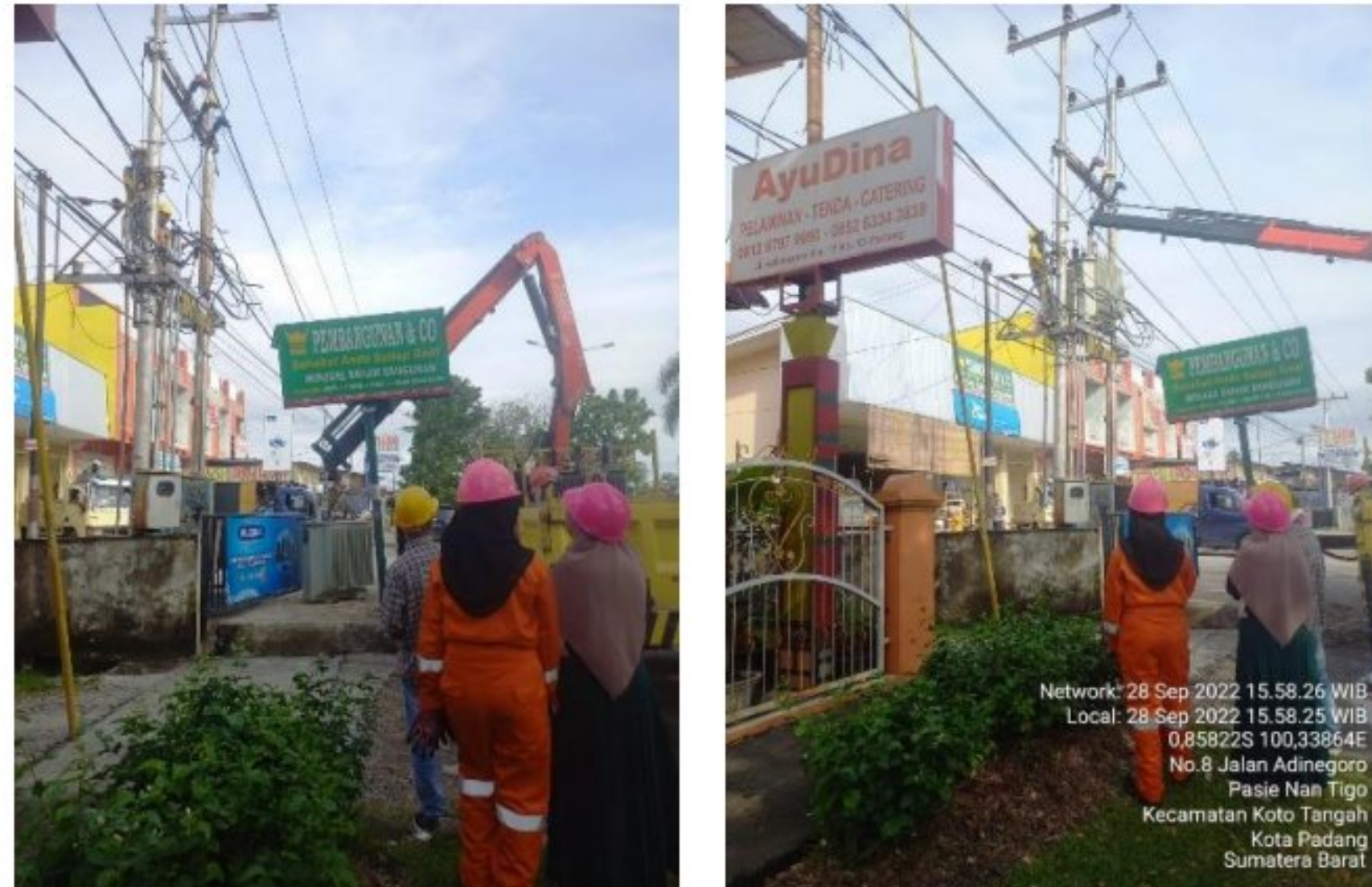
Gambar 2. 1 Pelaksanaan pergantian Trafo Distribusi
