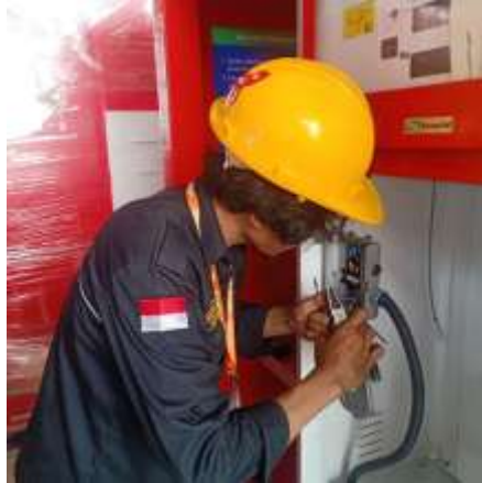
Gambar 14. Pemasangan Kabel Power
