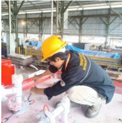
Gambar 16. Pemasangan kabel jumper grounding (Sumber: Dokumentasi Penulis)
