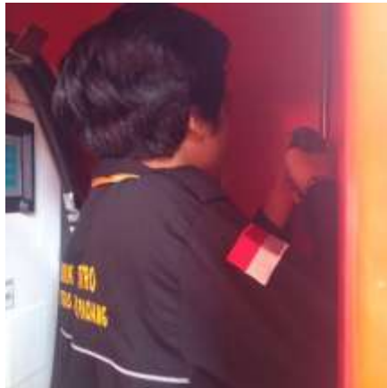
Gambar 15. Pengkleman kabel Power dan lampu pada dinding pertashop
