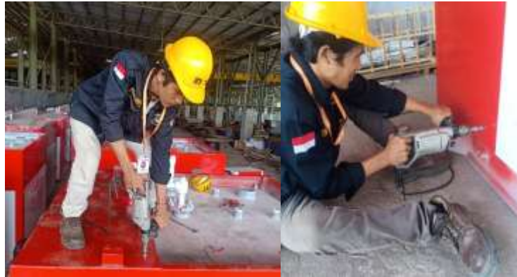
Gambar 13. Pengeboran Jalur Kabel pada Dinding Pertashop
