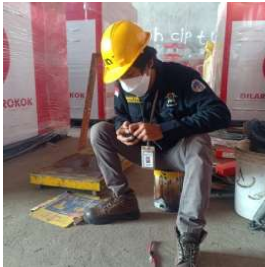
Gambar 12.pembuatan kabel jumper Grounding (Sumber: Dokumentasi Penulis)
