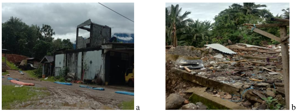
Gambar 5 1. (a) Bangunan runtuh dindingnya (b) Bangunan Hancur Rata dengan tanah (Dokumentasi Lapangan)
