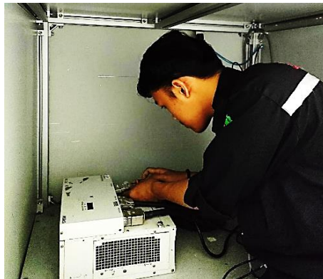
Gambar 2.55 Wiring Controller Robot RC 5.0 (Sumber : Dokumentasi Pribadi)
