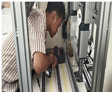
Gambar 2.41 Pemasangan DIN Rail dan Duckting
