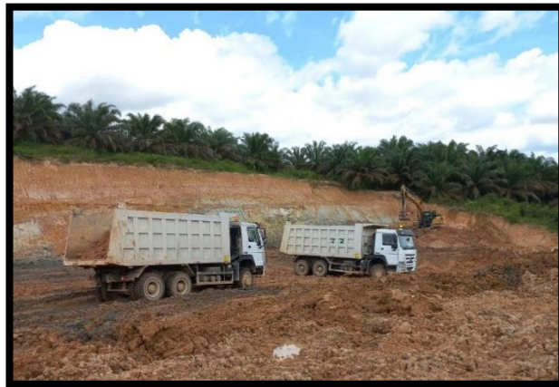
Gambar 11. Hauling Overburden PT. Pengembangan Investasi Riau
