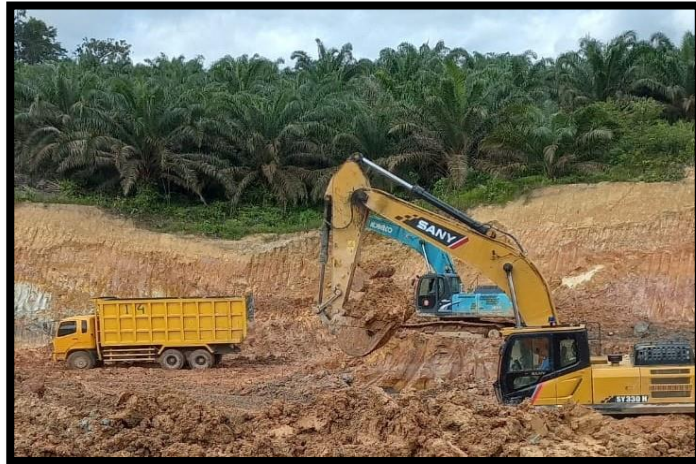
Gambar 15. Pengupasan Tanah Penutup
