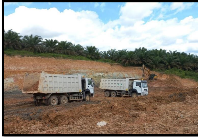
Gambar 12. Hauling Overburden PT Pengembangan Investasi Riau
