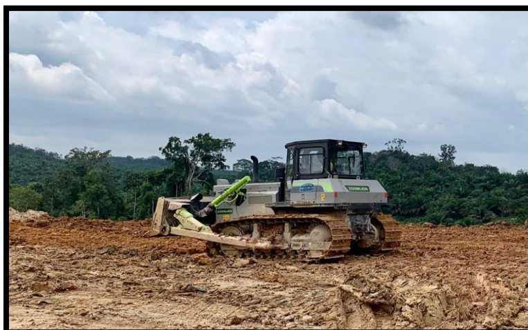
Gambar 15. Land Clearing menggunakan Bulldozer PT Pengembangan Investasi Riau
