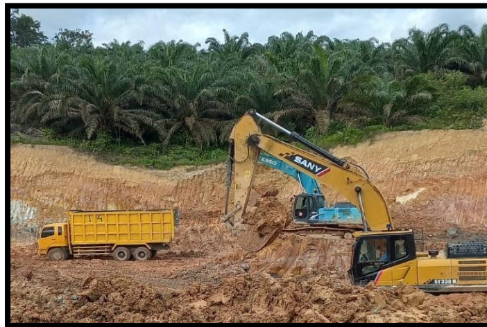
Gambar 25. Pengupasan Tanah Penutup
