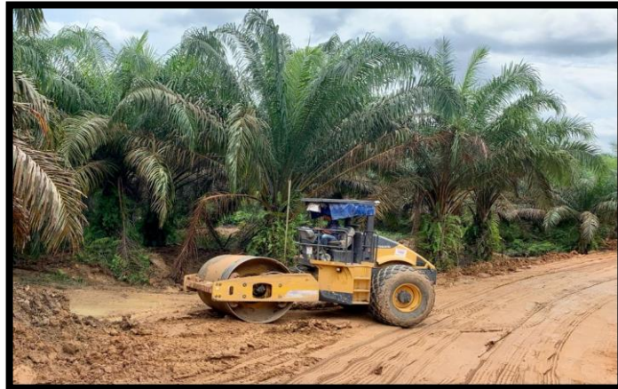
Gambar 18. Compactor Melakukan Pematatan Jalan Tambang
