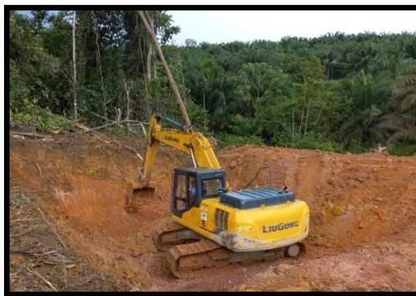
Gambar 10. Pengupasan Tanah Penutup PT Pengembangan Invetasi Riau
