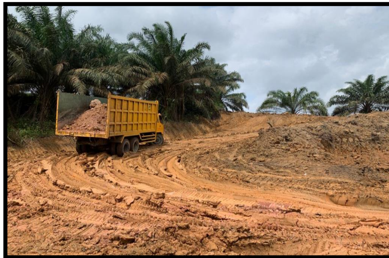
Gambar 32. Grade Jalan yang Tinggi
