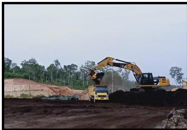
Gambar 22. Crusher Excavator PT Pengembangan Investasi Riau
