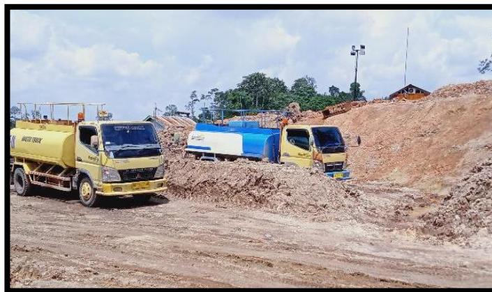
Gambar 20. Water Truck melakukan penyiraman Jalan Tambang
