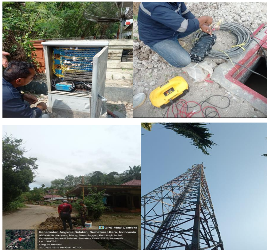
Gambar 12. Progres Pembangunan Jaringan Optik Melalui Konstruksi Via Kabel Tanah.
