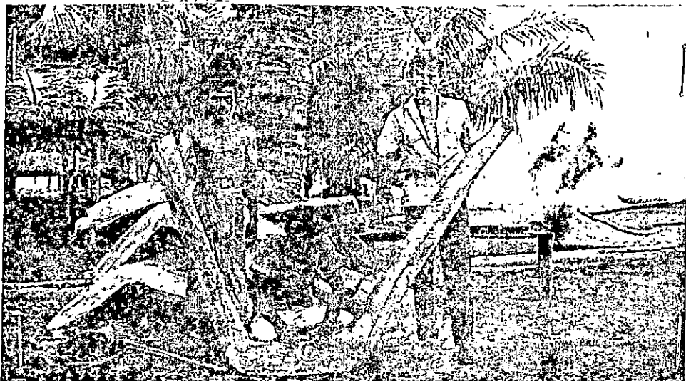
Gambar III.7 Bentuk Gading-gading yang Akan Dipasangkan pada Sirampu Sebagai Bahan untuk Pembuatan Bagan.
