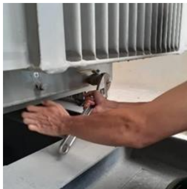
Gambar 17. Pembukaan drain valve bottom
