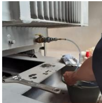
Gambar 19. Pembersihan endapan yang terdapat dalam minyak trafo
