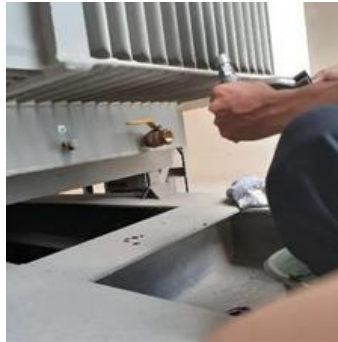
Gambar 18. Memasang konektor selang
