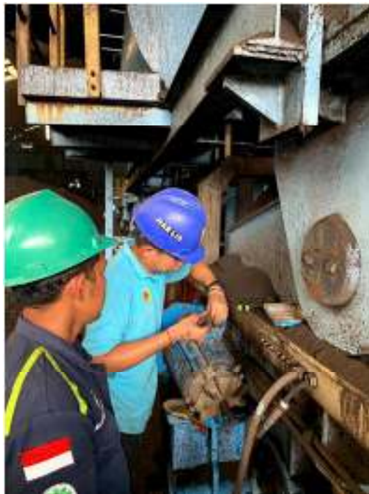
Gambar 4: Pemasangan Motor traveling stacker Reclaimer pada Coal Yard
