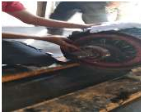
Gambar 21: Pemberian cairan Grease pada motor Belt Conveyor
