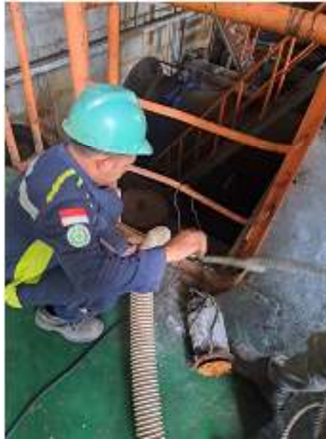
Gambar 5: Pemasangan Motor Sam Pump pada Circulating Water Pump
