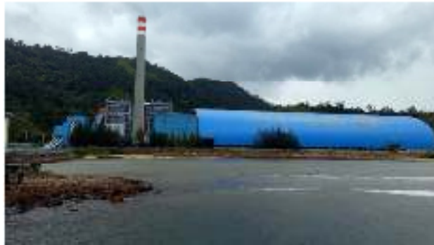
Gambar 2. Tampak dalam PT. PLN. INDONESIA POWER UPK Teluk Sirih
