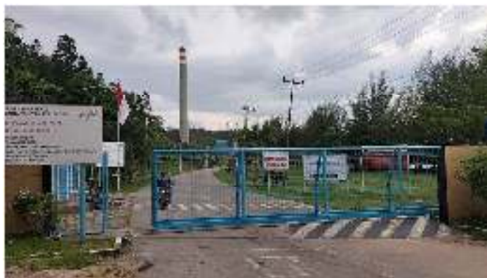
Gambar 1: Tampak Depan PT.PLN INDONESIA POWER UPK Teluk Sirih.
