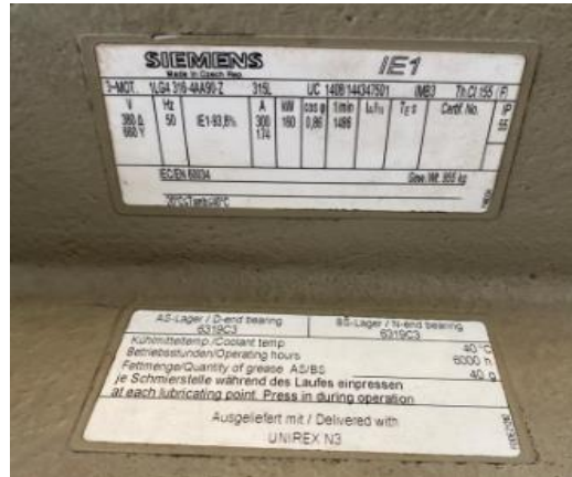
Gambar 2. 30 Namplate Motor ID FAN DCB 160 kW
