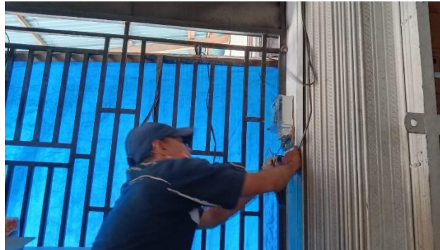
Gambar 4.8 pemasangan KWH meter
