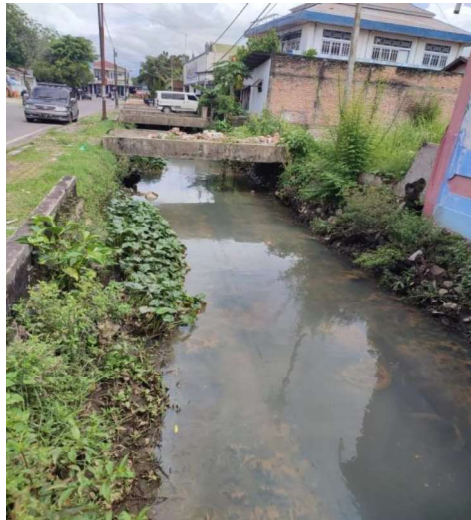
Gambar 1 Drainase di Jalan Bandar Damar – Jalan Ujung Gurun (Sumber: Dokumen Pribadi)
