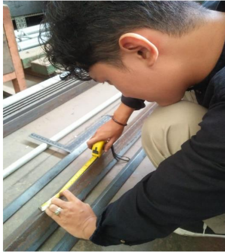
Gambar 16. Pengukuran Besi Menggunakan Meteran (sumber: Dokumentasi Pribadi,2022)
