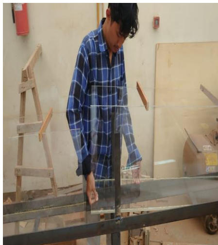
Gambar 13. Pekerjaan Pengeleman Akrilik (sumber: Dokumentasi Pribadi,2022)
