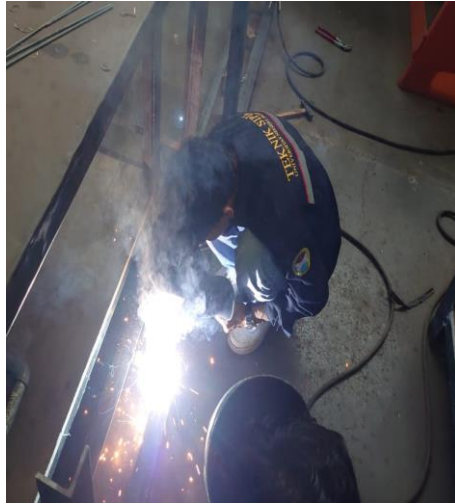
Gambar 8. Pekerjaan Pengelasan (sumber: Dokumentasi Pribadi,2022)
