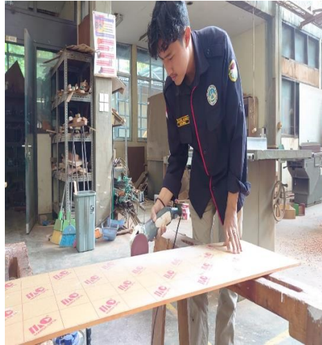
Gambar 12. Pekerjaan Pengamplasan Akrilik (sumber: Dokumentasi Pribadi,2022)
