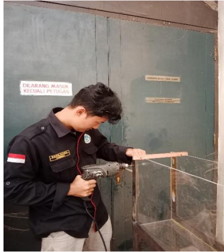
Gambar 9. Pekerjaan Pengeboran (sumber: Dokumentasi Pribadi,2022)
