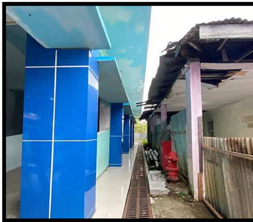
Gambar 1 : Lokasi Hidran Yang Cukup Sulit Diakses Sumber : Dokumentasi Pribadi
