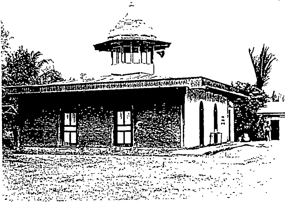
Gbr. 1 Lokasi Pembuatan Sumur Pipa (Mushalla Istiqamah)
