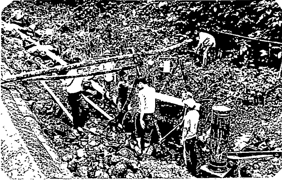
Gambar 22 Pemasangan Tabung Kompresor (Foto Dokumentasi)
