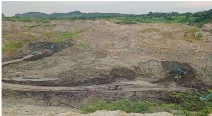
Gambar 2. Kondisi Pit Bulan Juni-Juli 2022
