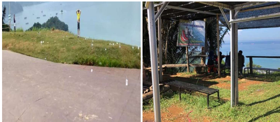
Gambar 9. Kondisi Tidak Ada Tempat Sampah & kondisi Tempat Duduk Sumber : Dokumentasi pribadi (2022)
