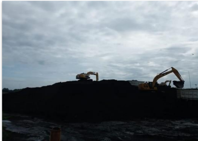
Gambar 1. Kondisi Stockpile PT. Pelabuhan Universal Sumatera
