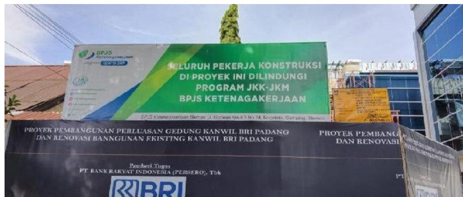
Gambar 4. Jaminan K3 yang dipaparkan pada lokasi proyek Sumber: Dokumentasi Pribadi (2022)
