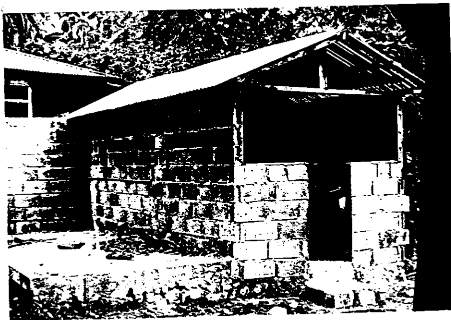
BANGUNAN WC UMUM DAN BAK PENAMPUNGNYA DI SEBELAH KIRI DAN SALURAN AIR DARI BAK SUMUR POMPA. KELIHATAN SALAH SEORANG WARGA DESA BERSAMA ANAKNYA MENGGUNAKANNYA.
