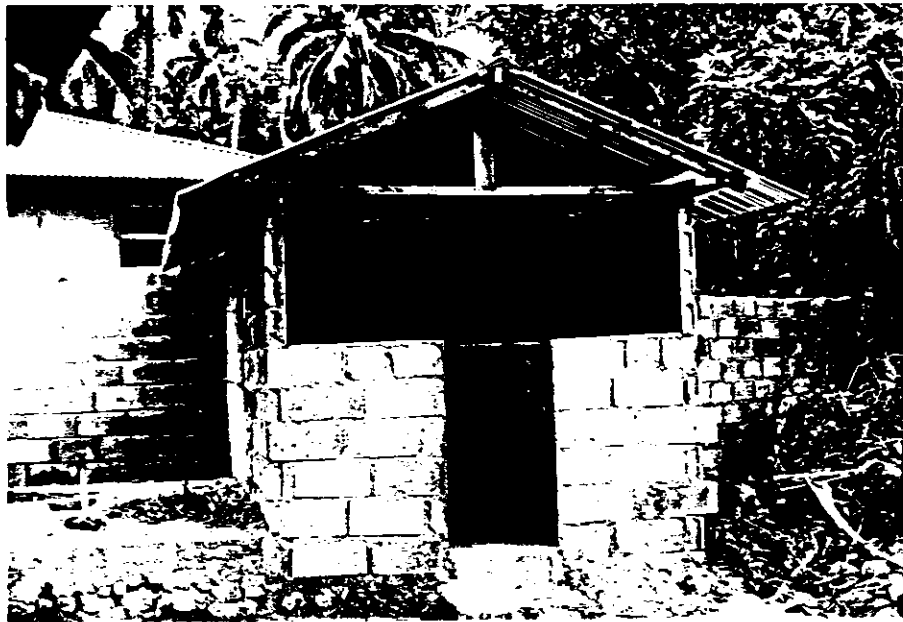
BANGUNAN WC UMUM DILIHAT DARI BELAKANG ( WC UNTUK WANITA ) UNTUK DUA ORANG SETELAH SIAP DI BANGUN DAN DIGUNAKAN.
