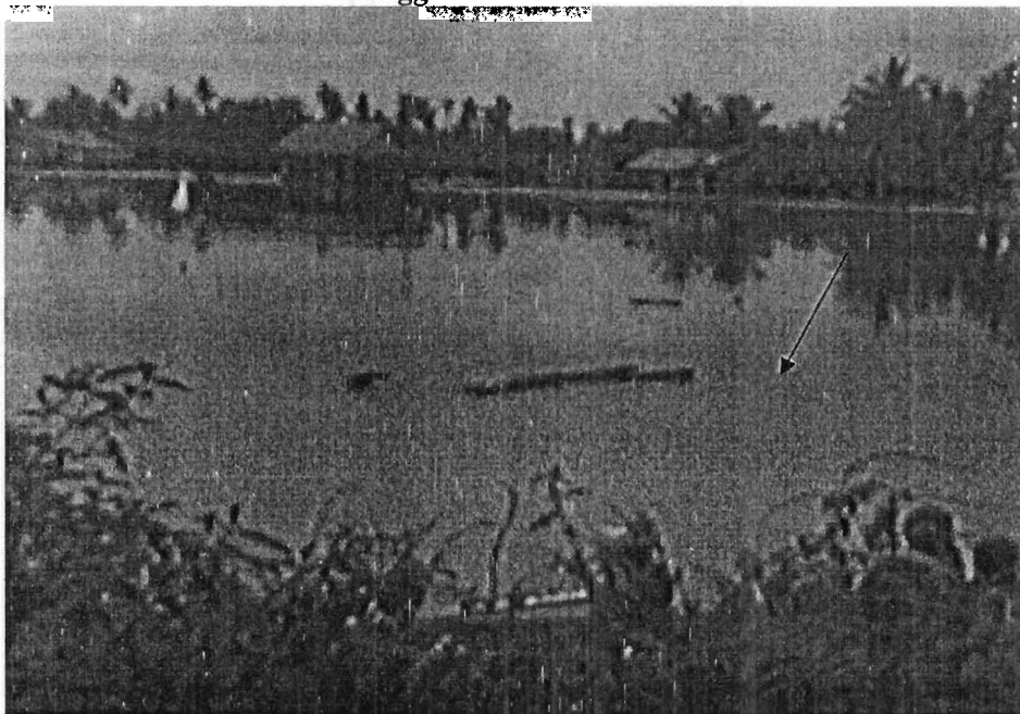
Gambar IV.7 Kondisi Banjir di Perumahan Sopo Inanta Tanggal 23 Januari 2007
