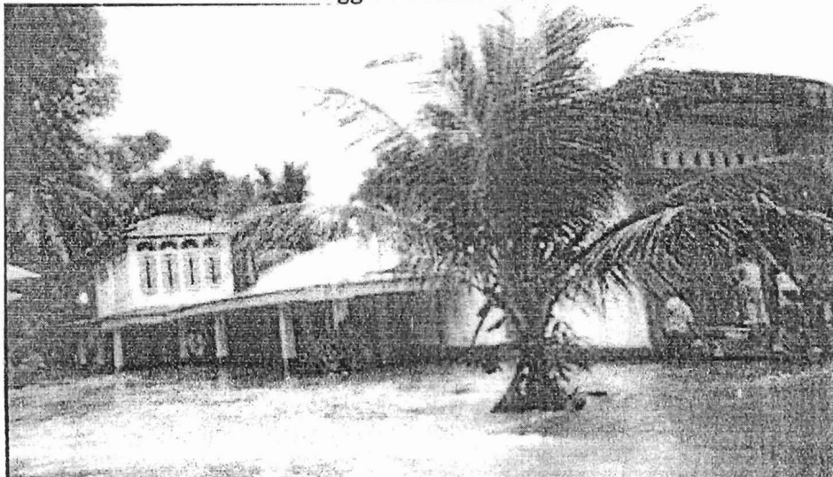
Gambar IV.2 Kondisi Banjir di Komplek Perumahan Jihat. Tanggal 27 Maret 2006
