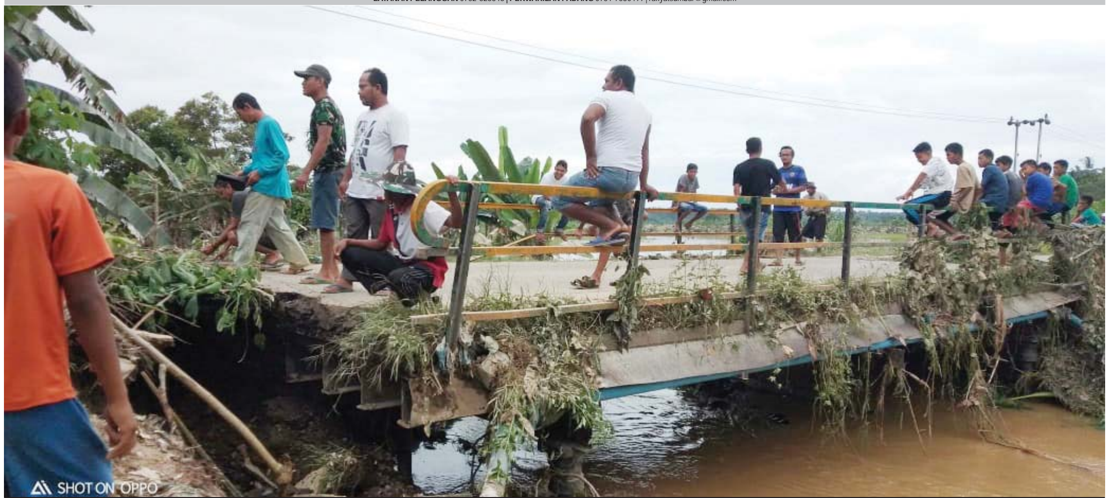
AMBLAS: Kondisi jembatan di Nagari Sitiung yang berada di jalan provinsi saat ini kondisinya yang amblas akibat tergerus air.
