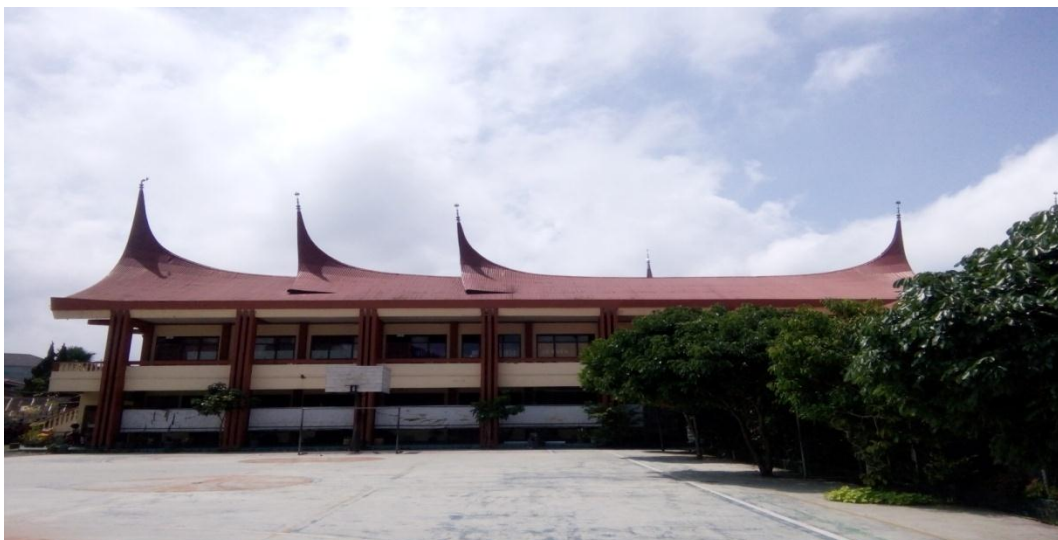
Gambar 6. Gedung SMK Negeri 1 Padang Panjang
