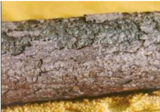
Gambar 1.6. Kerusakan Poros akibat Korosi
