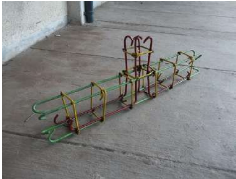
Gambar 5. Detail Penulangan Balok Ring-Kolom
