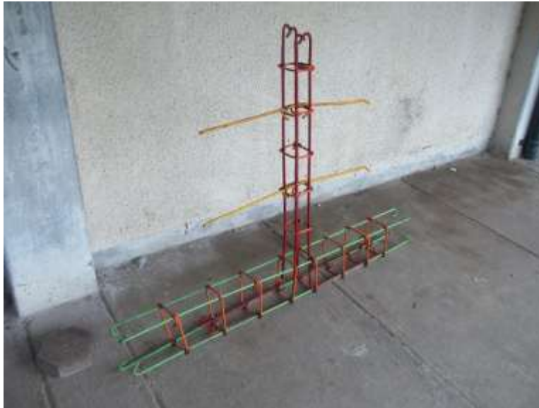
Gambar 3. Detail Penulangan Sloof-Kolom-Angkur Bata
