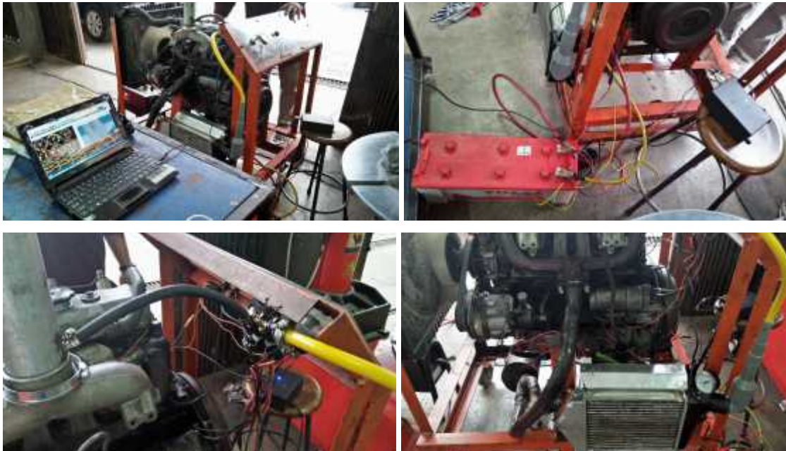
Gambar 5.9. Proses instalasi dan pengecekan kembali seluruh wiring kelistrikan sistem EGRICS yang terintegrasi dengan ECU dan PC komputer.
