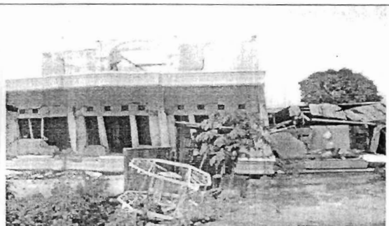
Rumah penduduk jalan ampang kec Kuranji
