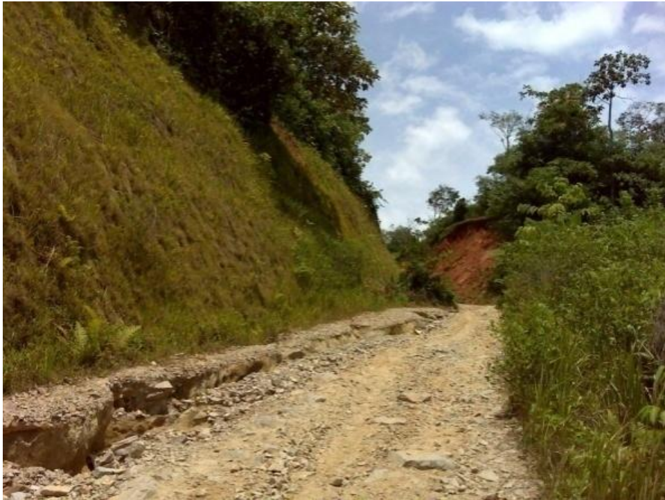
Gambar 3. Kerusakan Lingkungan Akibat Penambangan Biji Besi di Kenagarian Pulakek, Kecamatan Pauh Duo, Kabupaten Solok Selatan
